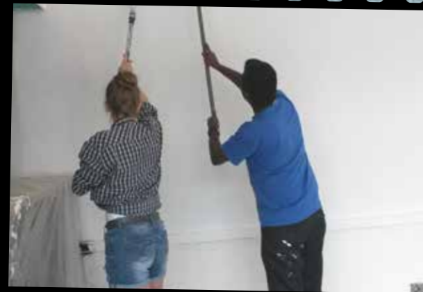
Renovierung des JUPP an der Josefkirche
